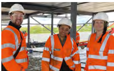
Los investigadores Craig Dawson, Happiness Ijije y Lisa Scullion en el sitio mientras los trabajadores atienden la primera losa de concreto mejorada.
