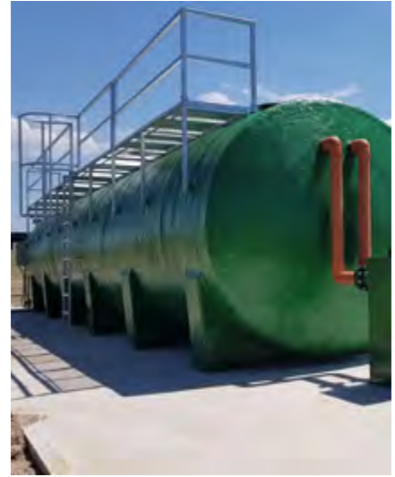
▲ Planta de tratamiento en PRFV 70 m 3 /d.
