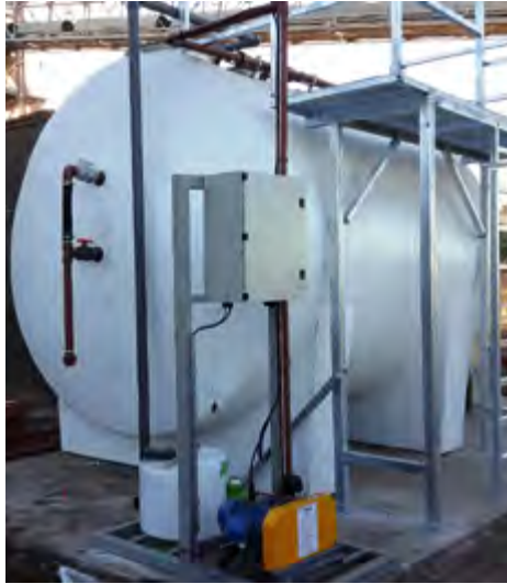
▲ Planta de tratamiento en PRFV 8 m 3 /d.
