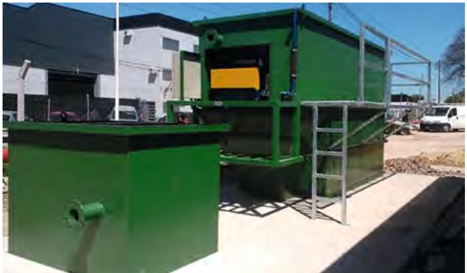
▲ Planta de tratamiento metálica 10 m 3 /d.
